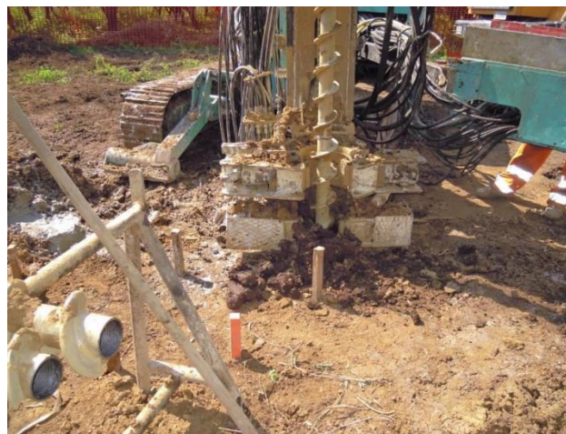
Figura 6.1-6 Tipico di realizzazione fondazioni su Micropali
