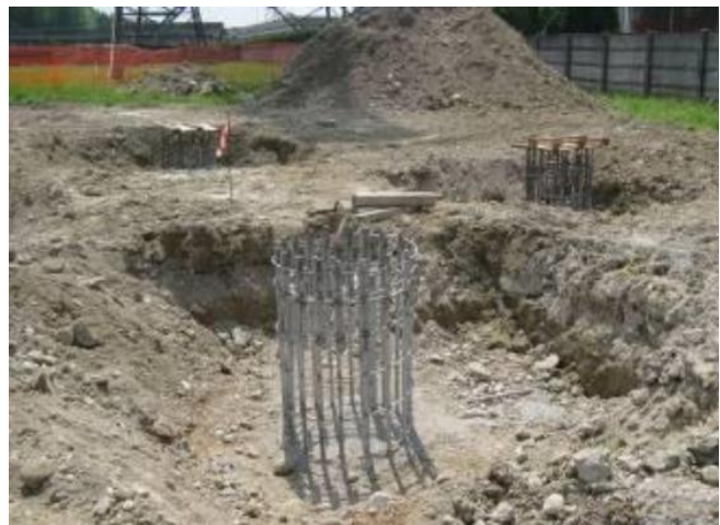
Figura 6.1-5 Tipico di realizzazione fondazioni su pali trivellati
