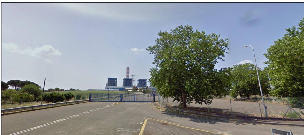
Figura 8.3-4 Località Pian dei Gangani, Montalto di Castro - SdC HVDC Montalto. Ripresa ravvicinata
