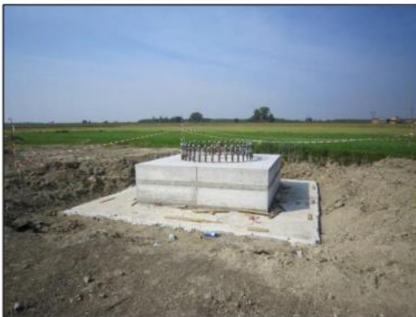
Figura 6.1-7 Realizzazione fondazione per sostegni tubolari
