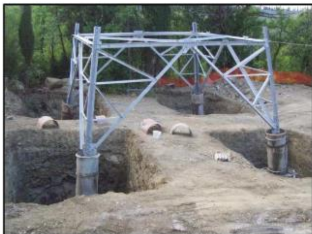
Figura 6.1-4 Realizzazione delle fondazioni
