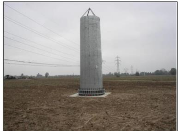
Figura 6.1-7 Realizzazione fondazione per sostegni tubolari
