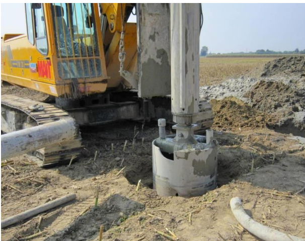
Figura 6.1-5 Tipico di realizzazione fondazioni su pali trivellati
