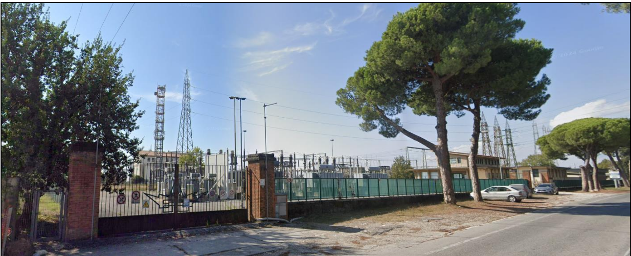
Figura 8.3-3 Località Avenza, Carrara – SdT aero/cavo HVDC Avenza. Ripresa ravvicinata
